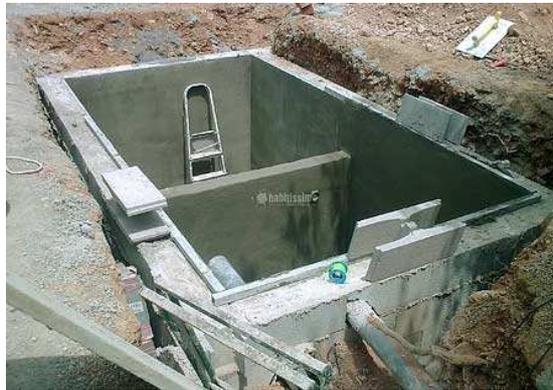
Imagen ilustrativa de una cámara séptica convencional
